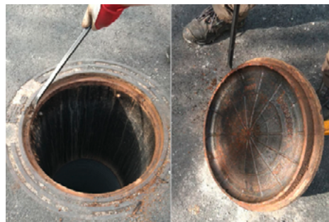
Joonis 9. Raami ja luugi kontaktpindade puhastamine kangiga
